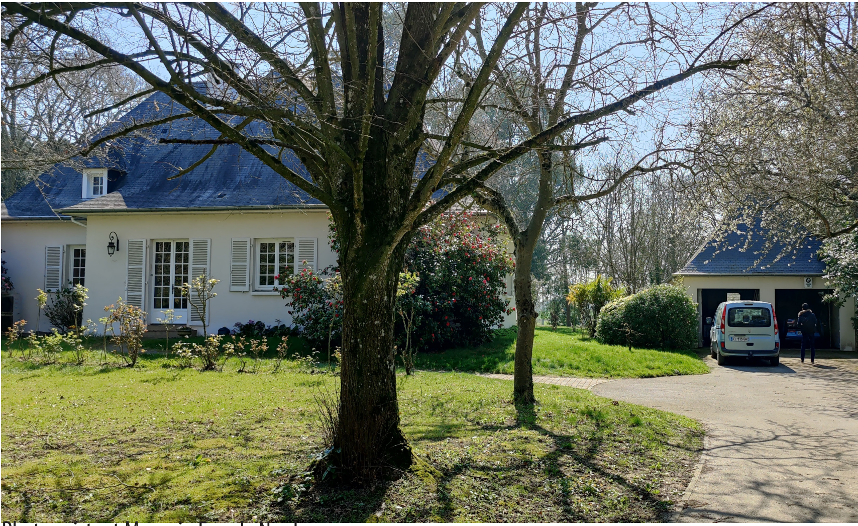
Photo existant Magasin façade Nord
