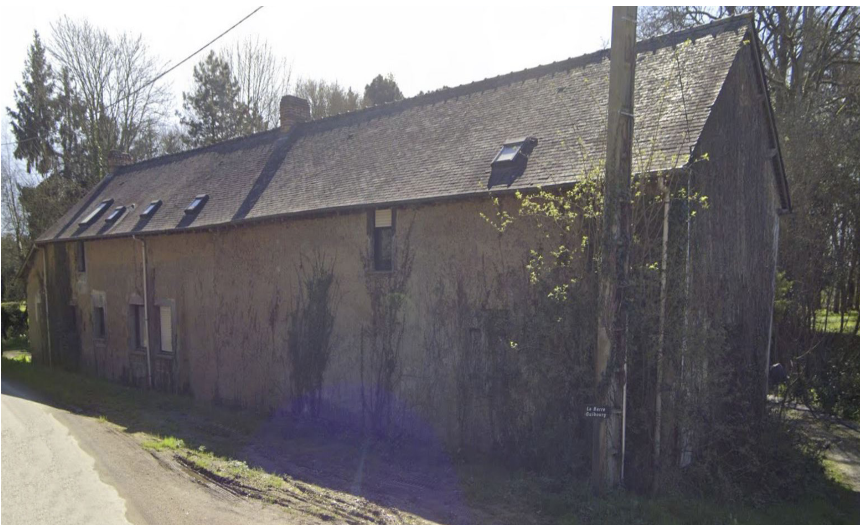
Photo existant Cidrerie façade Nord
